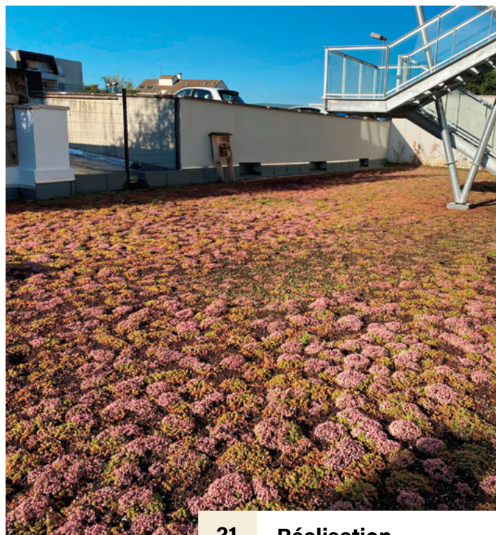
21 Réalisation Toiture végétalisée Tour Sigma Dijon Châlon-sur-Saône
