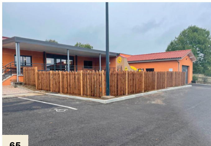
65 Aménagement Pose de clôture Mairie de Benqué-Molère
